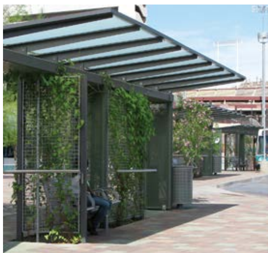
Tempe Transit Center - Tempe, AZ
